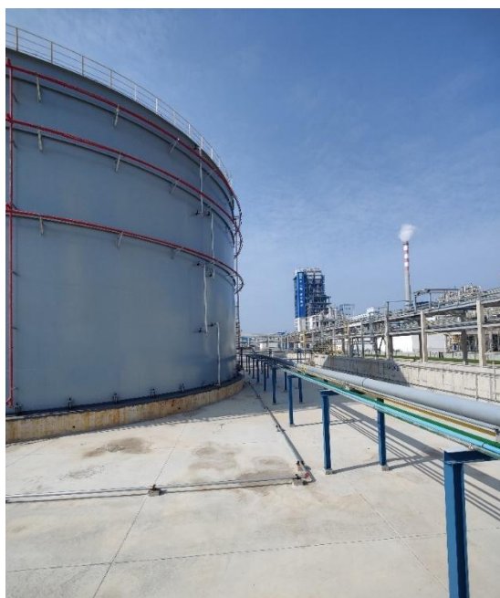
罐区围堰、可燃气体报警装置、导流沟、地面防渗
