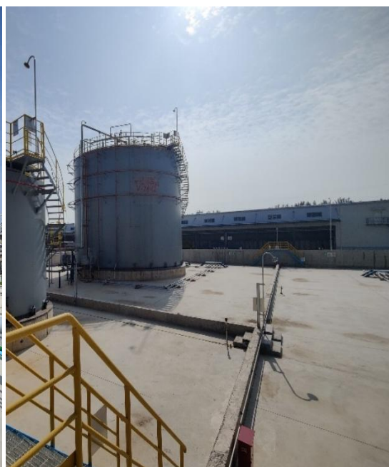
罐区围堰、可燃气体报警装置、导流沟、地面防渗
