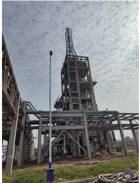
SCR 脱硝+硫酸雾捕集器+双氧水洗涤+湿式电除雾器+60m 排气筒 DA070
