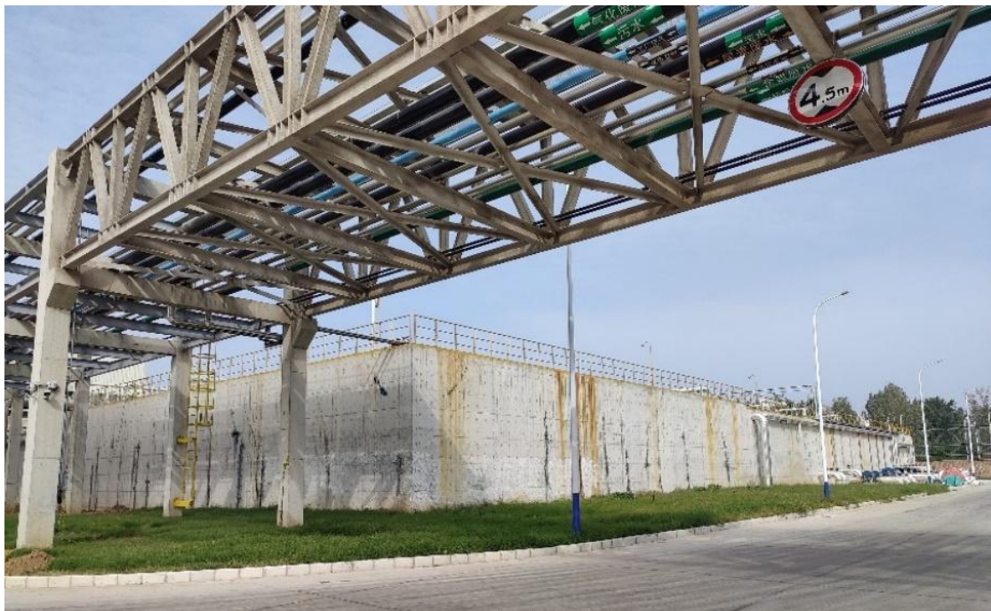
污水处理装置及事故池
