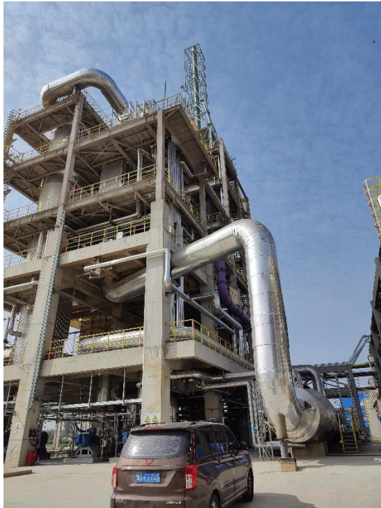
SCR 脱硝+硫酸雾捕集器+双氧水洗涤+湿式电除雾器+60m 排气筒 DA070
