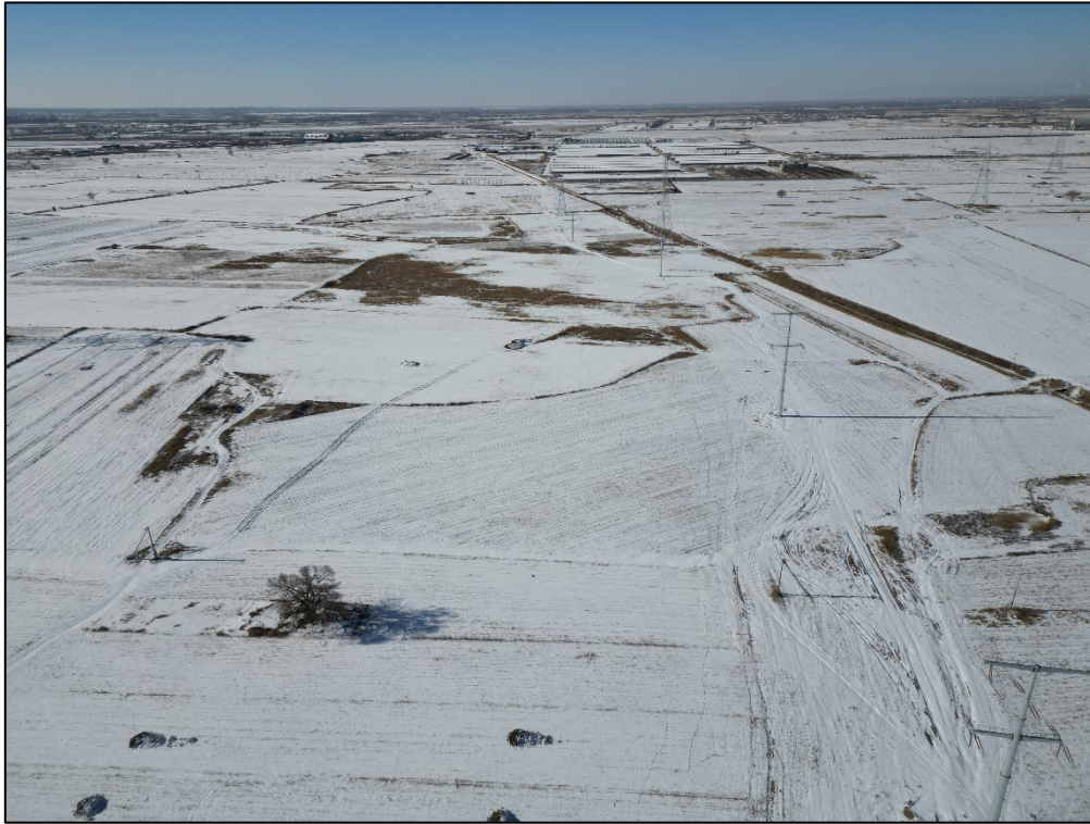
输电线路新建段杆塔塔基处植被恢复
