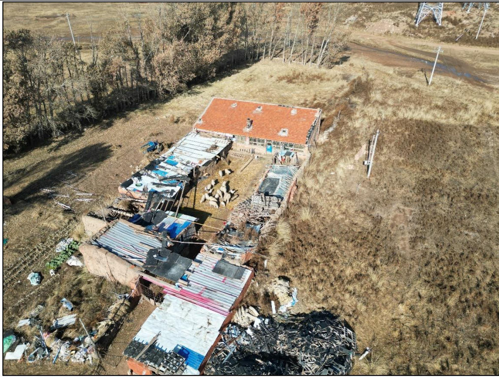
变电站南侧居民点
